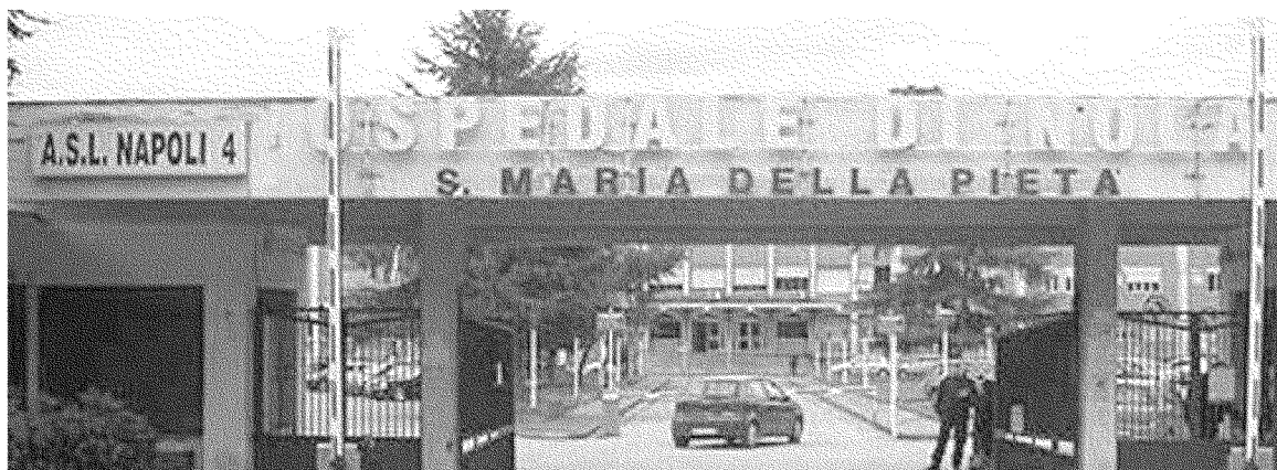
LA STRUTTURA Il pronto soccorso di Nola
